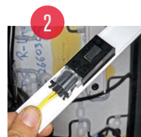
2 Fußraum-Leuchte anstecken und in passend erstellten Ausschnitt einrasten
