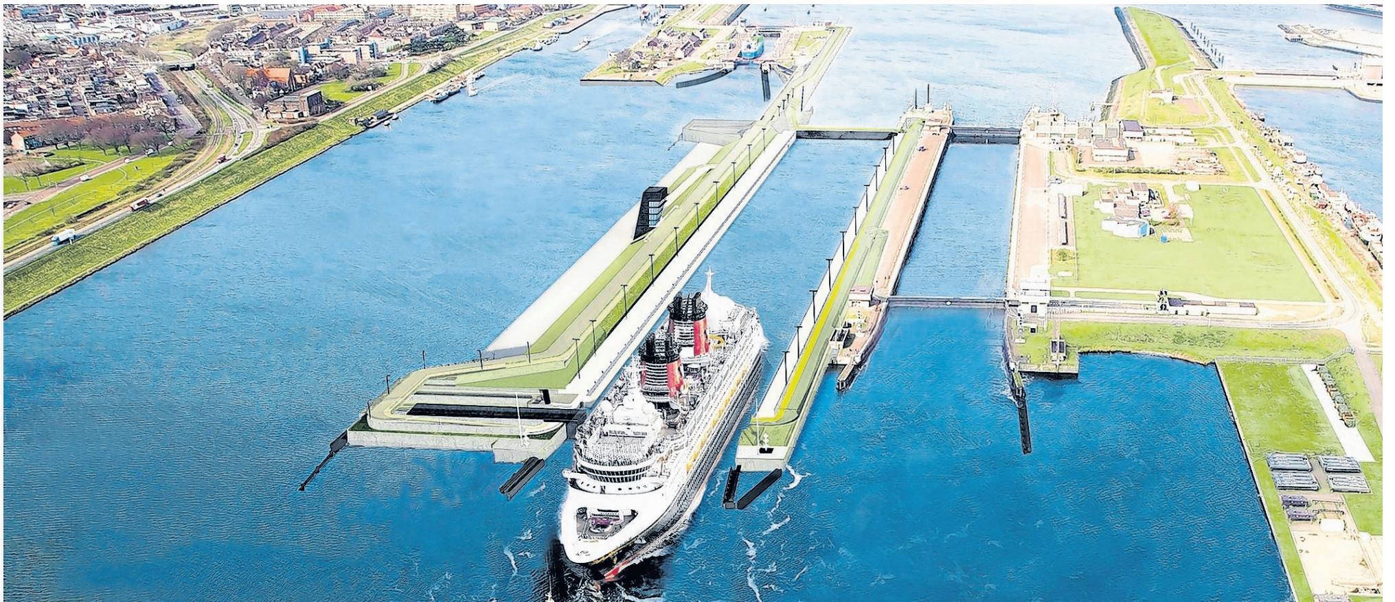
▲ 'Zorgt het plan voor Havenstad in Amsterdam (75.000 woningen) er niet voor dat de bouw van de nieuwe Zeesluis in IJmuiden straks een desinvestering is?' FOTOSTUDIO HONING
