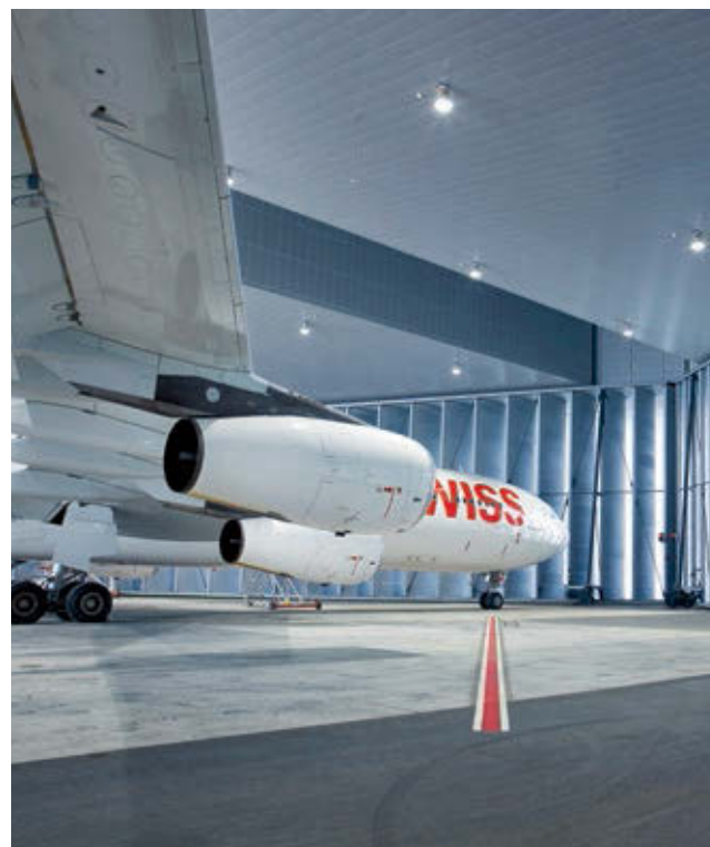
In der Schallschutzhalle werden Triebwerk-Probelaufe durchgeführt.
