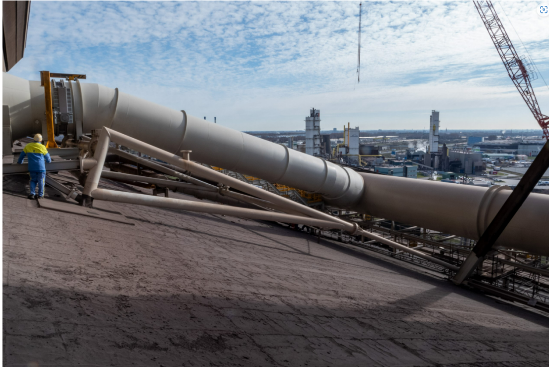
Figuur 4.8 De buizenconstructie van de tertiaire afzuiginstallatie op het dak van de Staalfabriek
