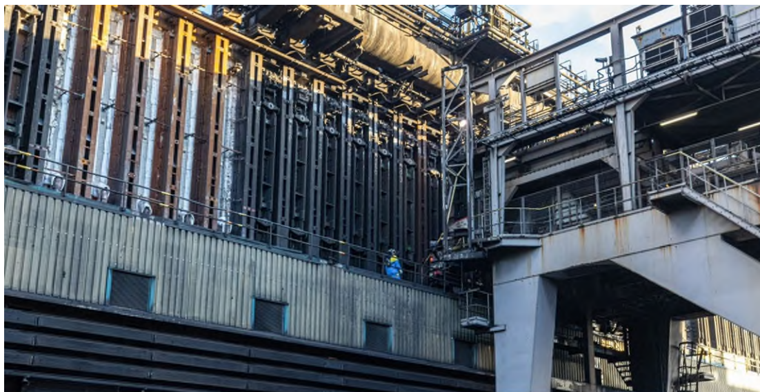
Figuur 4.12 Foto van Kooksfabriek 2, met links in beeld een kookskamer (met vijf deuren) die gereviseerd wordt
