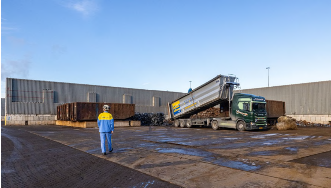
Figuur 4.21 De geluidswerende muren in het schrootpark
