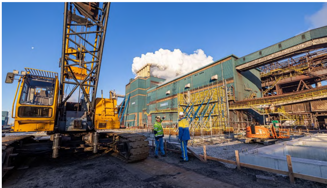
Figuur 4.9 De bouwwerkzaamheden van de Ontstoffings- en DeNOx-installatie bij de Pelletfabriek
