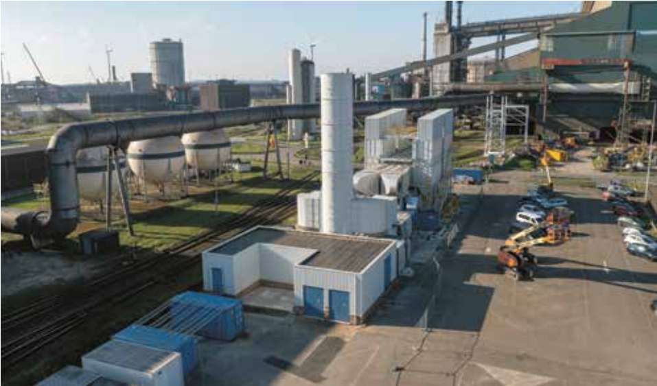
Imposant leidingwerk op het dak van de Staalfabriek om de extra afzuigkap in de fabriek te verbinden met de doekfilterinstallatie buiten de fabriek.
